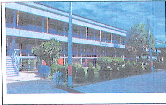
ภาพถ่ายด้านหน้าอาคาร
